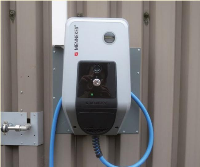
Bild 8: Wallbox mit Zugriffsbeschränkung (Schlüssel) und angeschlagenem Kabel
