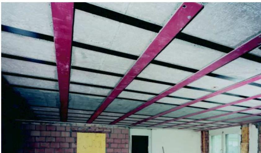
Abbildung 1 Beispiel aufgeklebte CFK- und Stahllamellen
